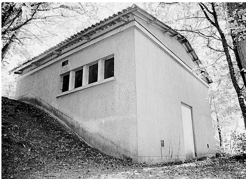
Das Reservoir Schaffersbuck muss erneuert werden – von hier aus werden die Gemeinden des Stammertals mit Wasser versorgt. Bild Mark Gasser
